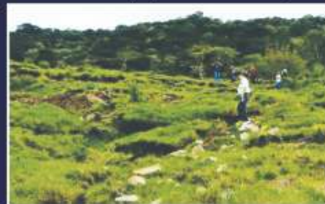
Foto 11. Ruptura de pasto y suelo
