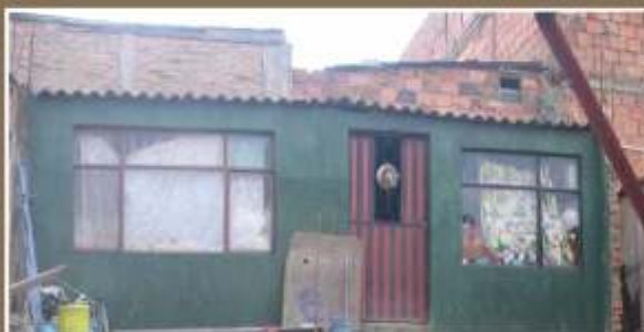
Tipología B2: Construcciones de calidad regular o mala. No tienen refuerzo estructural ni fundación adecuados.
