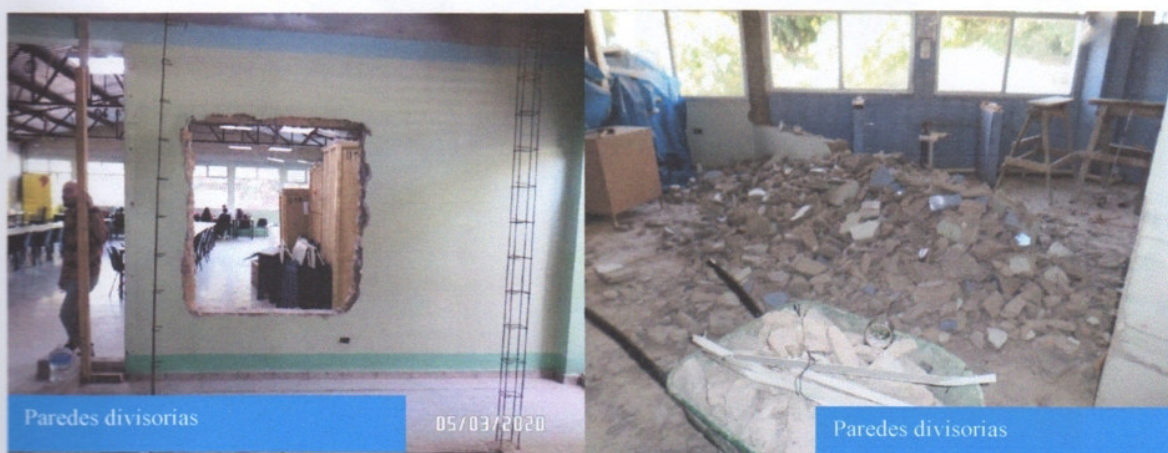
Demolición de Pared
