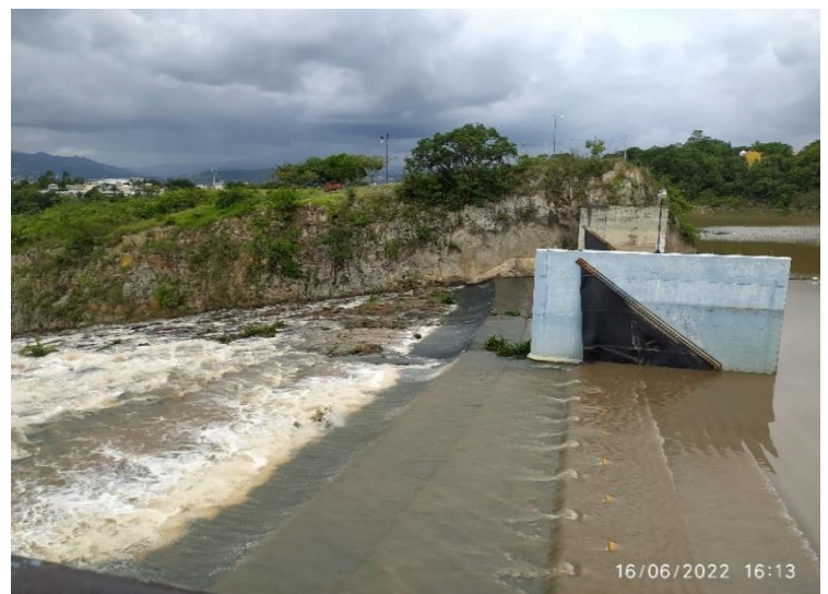
Cortina Represa Los Laureles Proyecto para Fortalecer la Prestación de Agua Potable de Tegucigalpa
