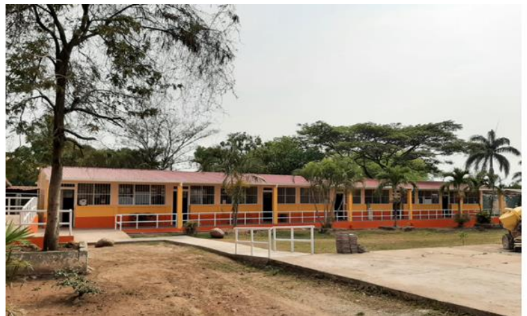
Reparación CEB Marcelino Pineda López Proyecto Recuperación de Emergencia A Causa de Ciclones Tropicales Eta e Iota (PRE)
