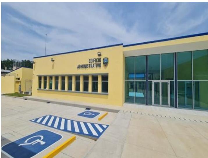
Edificio Administrativo, las Vegas Santa Bárbara Programa de Convivencia y Mejoramiento de Barrios
